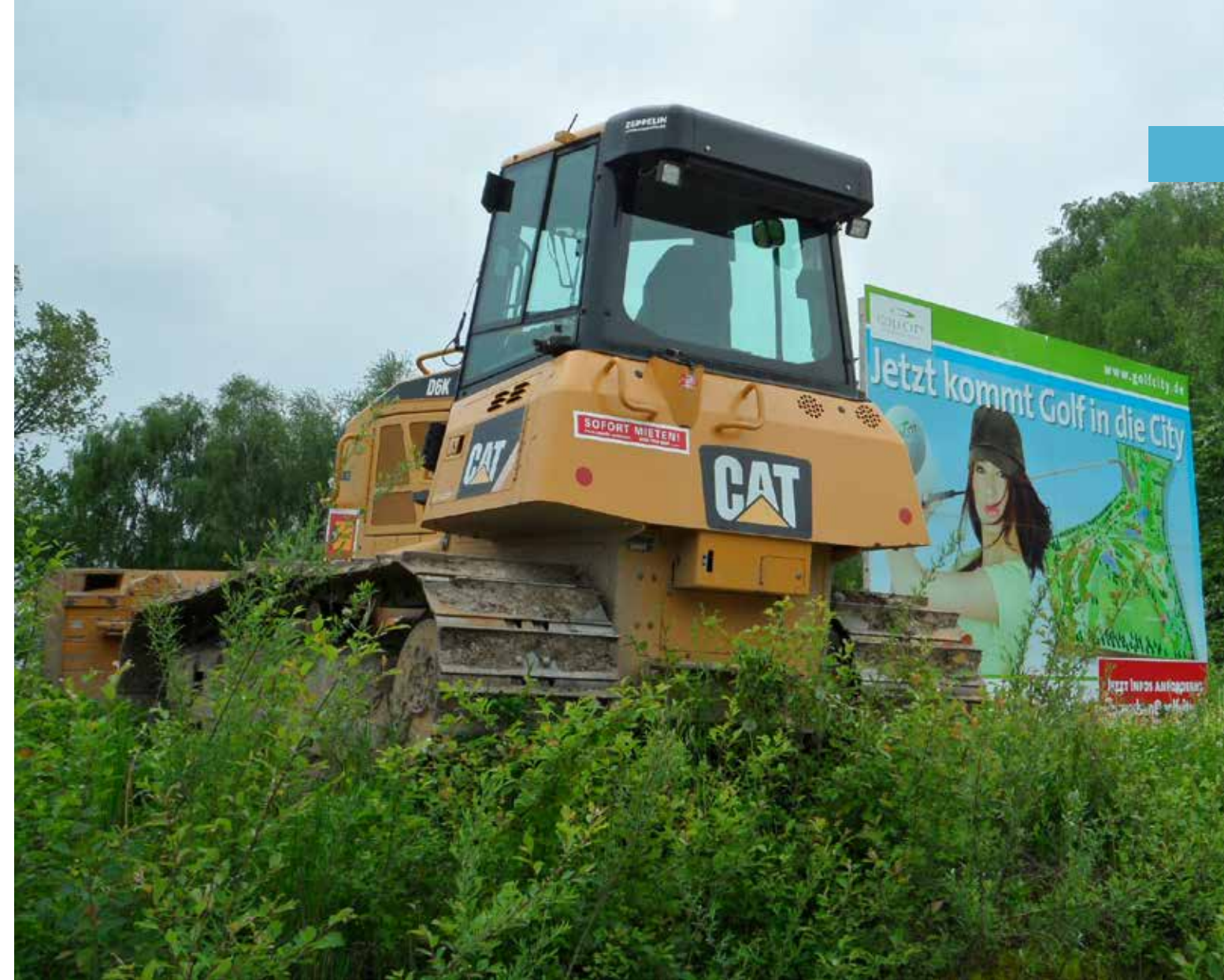
Schon nach kurzer Zeit rückten die Bagger auf dem Gelände in München an.
